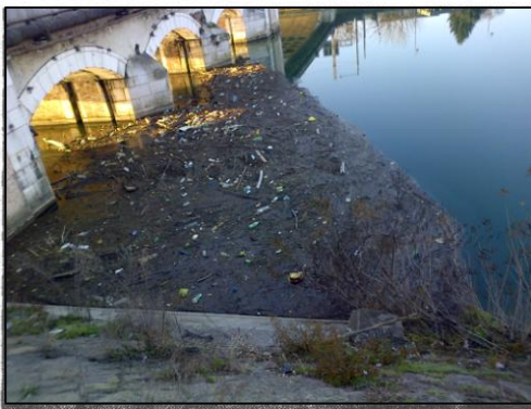
L'INTOPPO Sotto il ponte al Bassanello l'isola dei rifiuti
